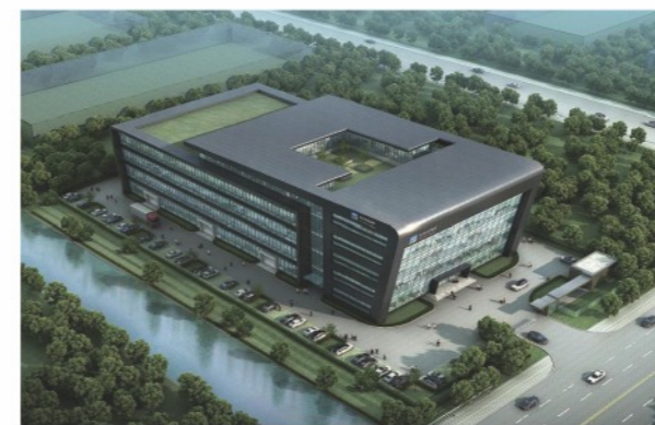
▪ 上海市工厂 Shanghai Factory
